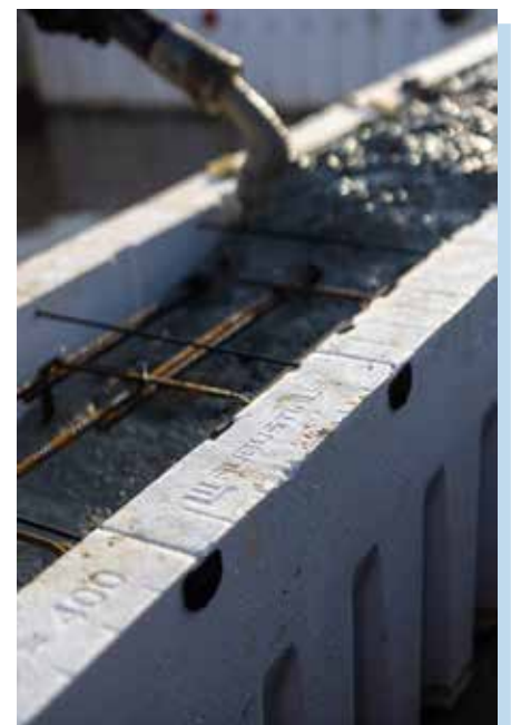
Das U-Schalen-Element in seiner Anwendung beim Betonieren eines Fundaments
